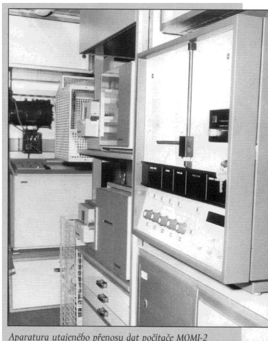
Aparatura utajeného přenosu dat počítače MOMI-2
