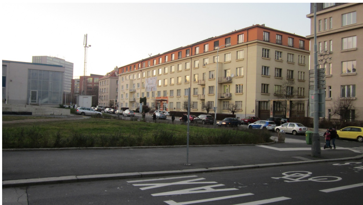
Hlavní budova VÚSTE, Velflíkova 4 v Praze Dejvicích – stav v roce 2020
